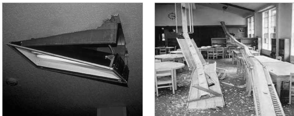
Figura 13.3. Danni causati dal crollo di sistemi di illuminazione
