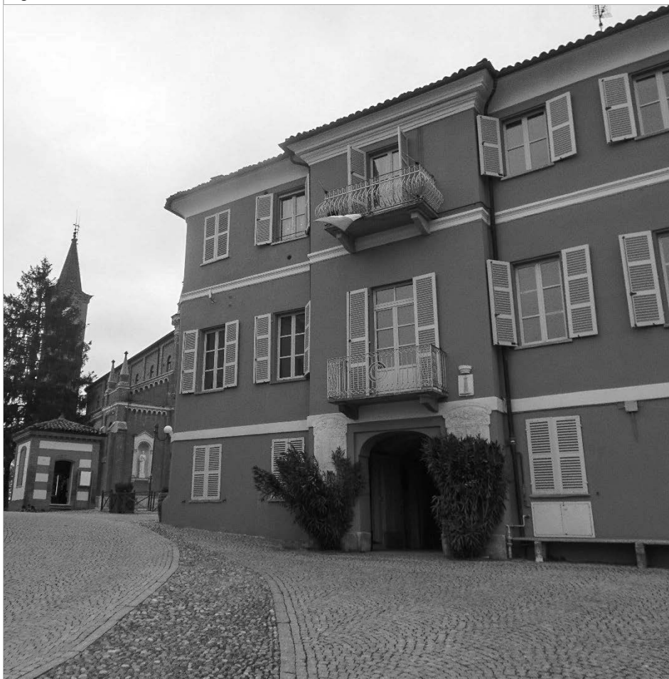
Figura 10.2. Facciata principale edificio oggetto di intervento
