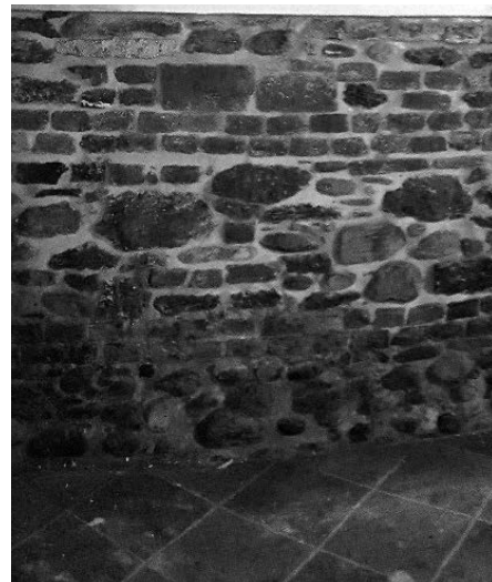
Figura 8.2. Presenza massiccia di umidità sulle pareti interne
