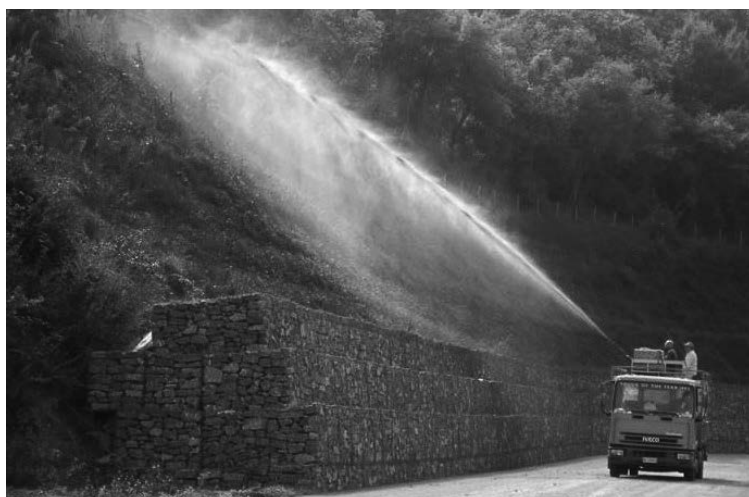
Figura 3.1. Idrosemina su pendio (gentile concessione Pratiarmati®)
