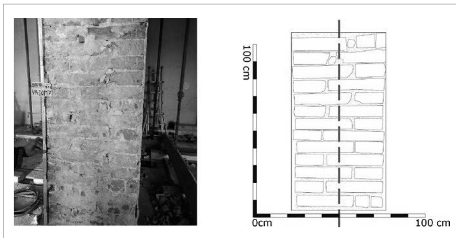
Figura 2.3. Presenza di elementi trasversali che si estendono oltre la metà della sezione muraria.
