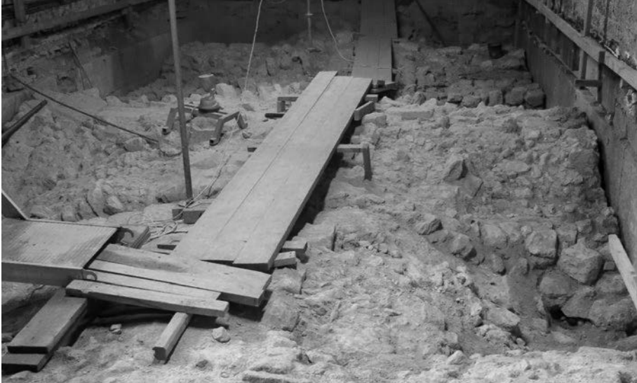
Figura 5.2. Vista dell'estradosso della copertura voltate del narcece.
