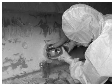
Figura 5.2. Rimozione di colla per piastrelle contenente amianto
