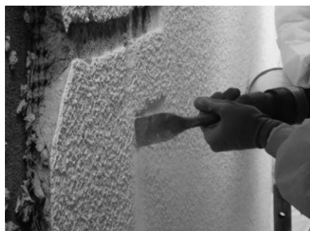
Figura 5.1. Rimozione di intonaco contenente amianto
