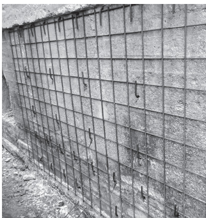
Figura 12.1. Incamiciatura con intonaco armato
