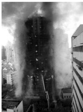
Figura 1.1. Edificio di grande altezza interessato da incendio.
