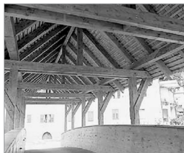
Fig. 17.3. A sinistra, ponticello in legno non protetto da legno trentino; a destra ponticello in legno coperto (protetto), da: legno trentino
