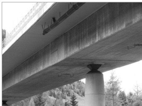
Fig. 7.4. Bellinzona, particolare appoggio a calotta sferica, che funziona come una cerniera spaziale
