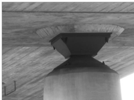
Fig. 7.4. Bellinzona, particolare appoggio a calotta sferica, che funziona come una cerniera spaziale
