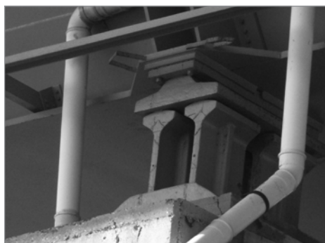
Fig. 7.3. Appoggio a cerniera in acciaio a lavagna
