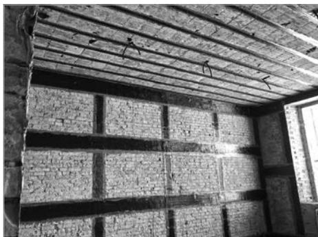
**Figura 12.2.** Consolidamento di murature con CFRP
