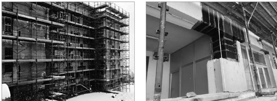
**Figura 12.1.** Consolidamento di nodi perimetrali con CFRP
