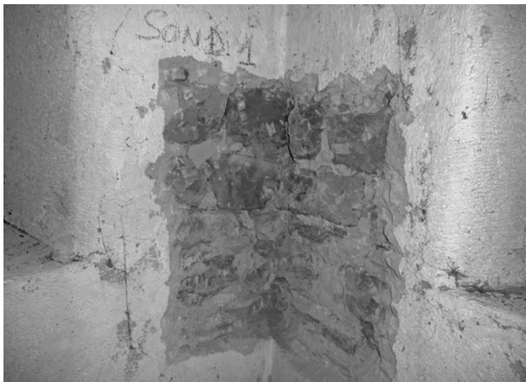
Figura 3.1. Ispezione diretta tessitura muraria
