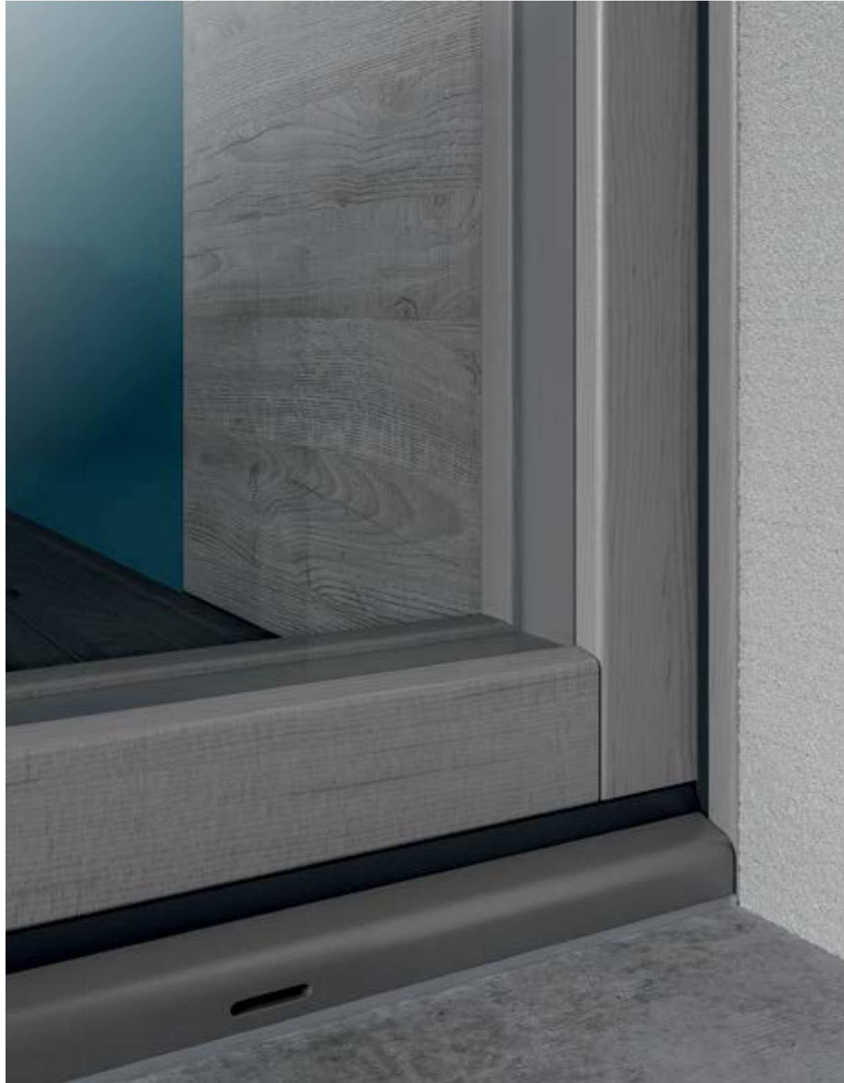
Dettaglio portafinestra con gocciolatoio in alluminio Window detail with aluminum drip
