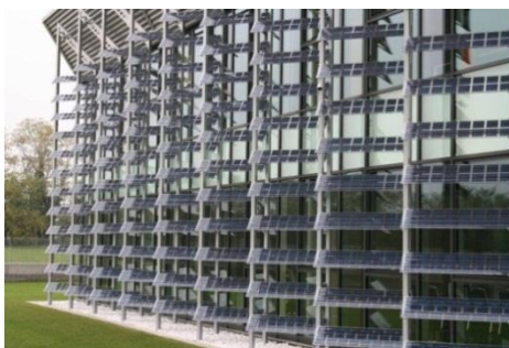
Fig.23 – Esempio di installazione idonea alla classificazione dell’impianto fotovoltaico nella categoria “su edifici”
