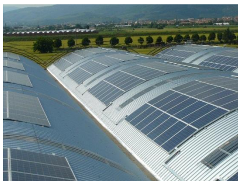
Fig.15 – Esempio di installazione idonea alla classificazione dell'impianto fotovoltaico nella categoria "su edifici" in caso di installazione su una superficie di copertura curva
