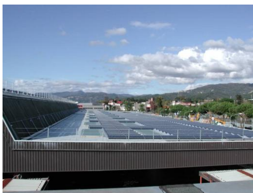
Figura 2 – Esempio di installazione idonea alla classificazione dell'impianto fotovoltaico nella categoria "su edifici" in caso assenza di una balaustra perimetrale
