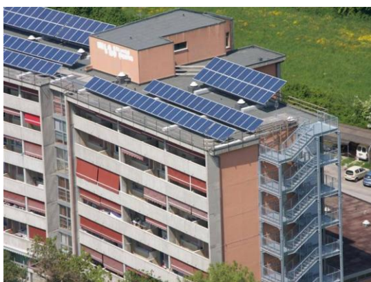
Figura 5 - Esempio di installazione non idonea alla classificazione dell'impianto fotovoltaico nella categoria "su edifici" – Motivazione: l'elemento perimetrale non può essere considerato balaustra e la quota massima dei moduli supera i 30 cm
