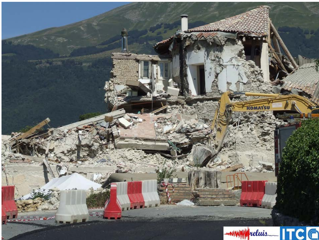
Figura 29 – Collasso totale di un edificio
