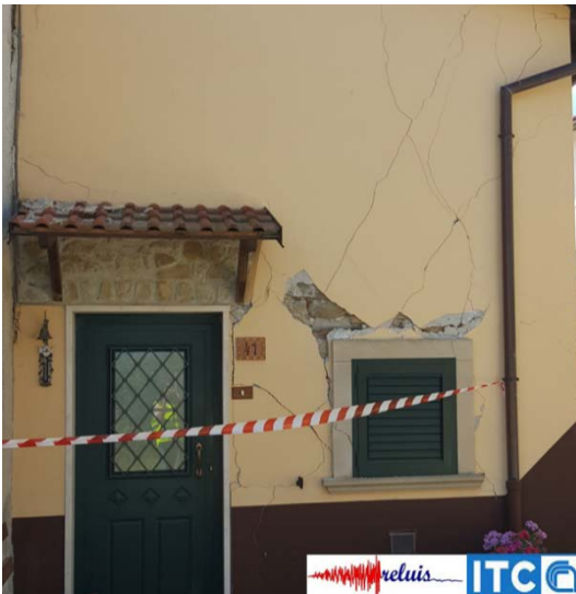
Figura 2 – Fessurazione diagonale per crisi a taglio di edifici in muratura
