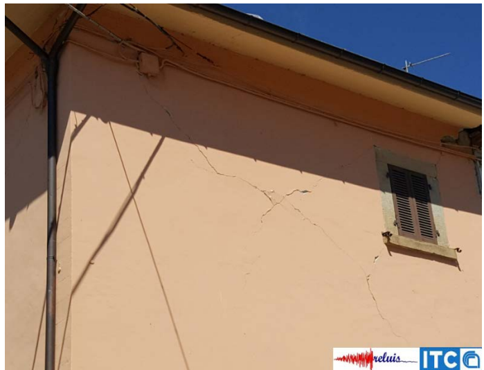
Figura 2 – Fessurazione diagonale per crisi a taglio di edifici in muratura
