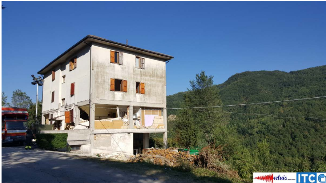
Figura 41 - Vista generale di un edificio in cemento armato danneggiato dal sisma
