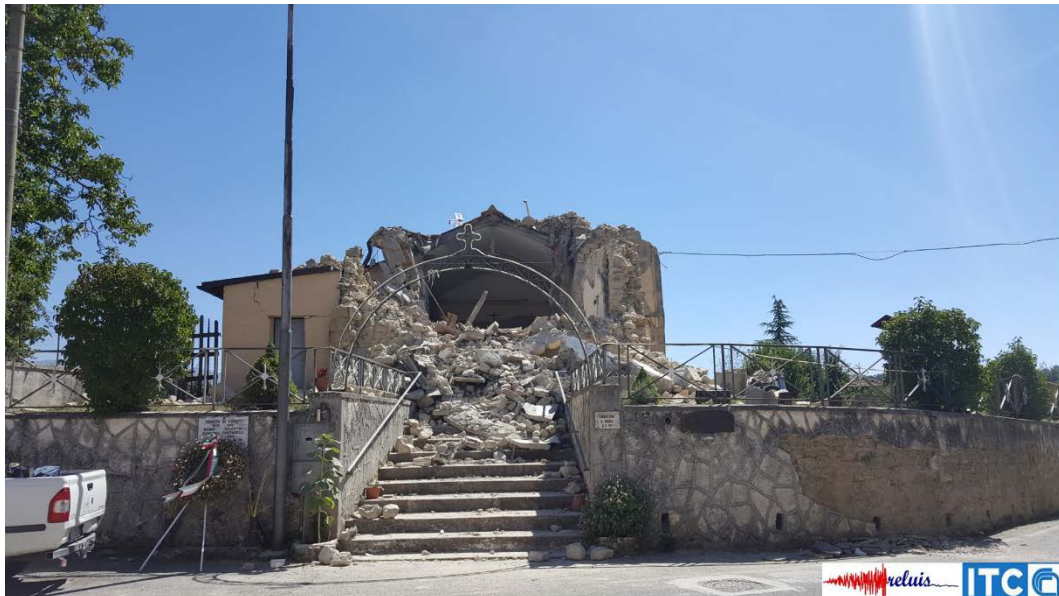
Figura 3 – Crollo della facciata e del timpano di una chiesa in muratura
