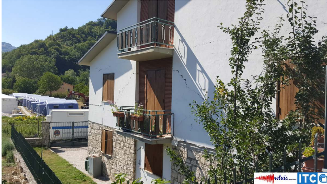
Figura 31 – Edificio in muratura: lesioni diagonali per crisi a taglio delle pareti perimetrali
