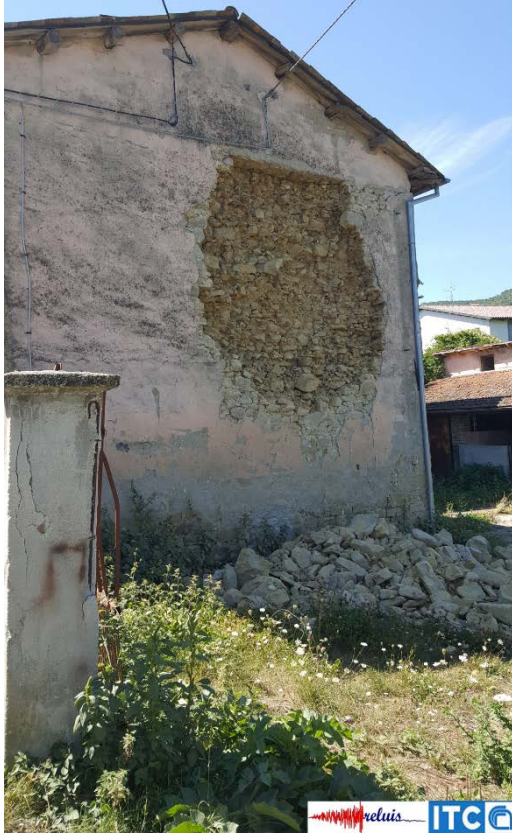
Figura 6 - Collasso dello strato esterno di una parete in muratura
