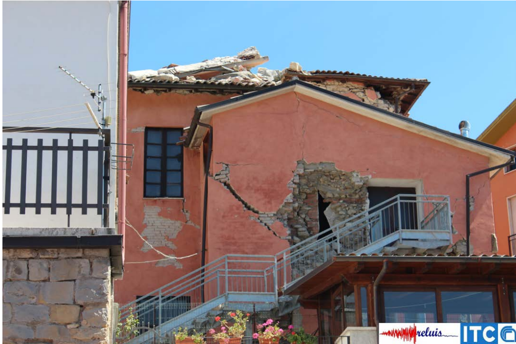
Figura 28 – Crisi a taglio della muratura con lesione diagonale
