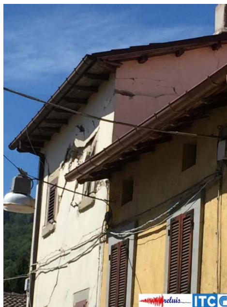
Figura 8 - Fessurazione diagonale per crisi a tagli dei pannelli murari e lesione orizzontale in corrispondenza del tetto in un edificio in muratura
