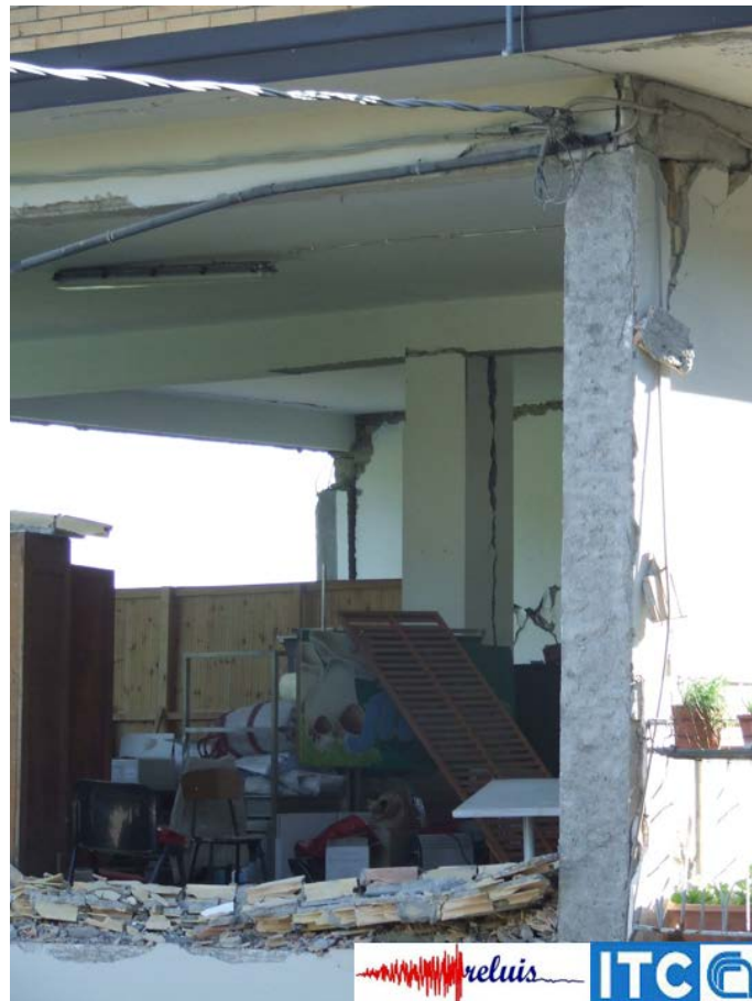
Figura 46 – Edificio in cemento armato: particolare del danneggiamento di un pilastro interno
