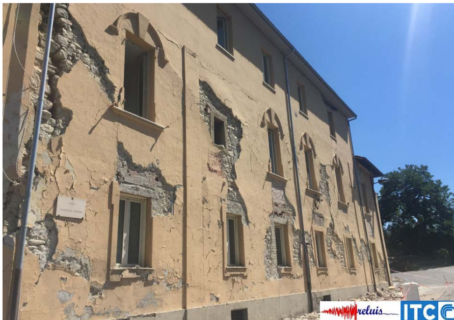
Figura 17 – Ospedale F. Grifoni, porzione in muratura: esteso danneggiamento della muratura
