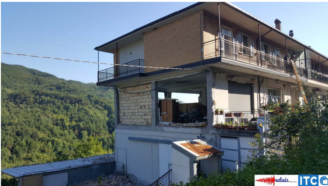
Figura 44 – Vista generale di un edificio in cemento armato danneggiato dal sisma
