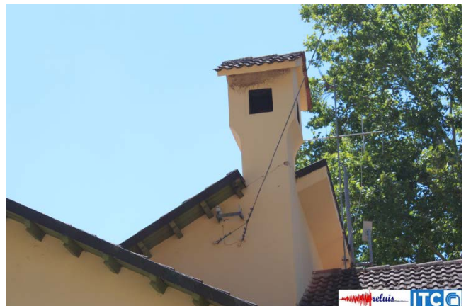
Figura 22 – Danneggiamento del componente non strutturale (comignolo)
