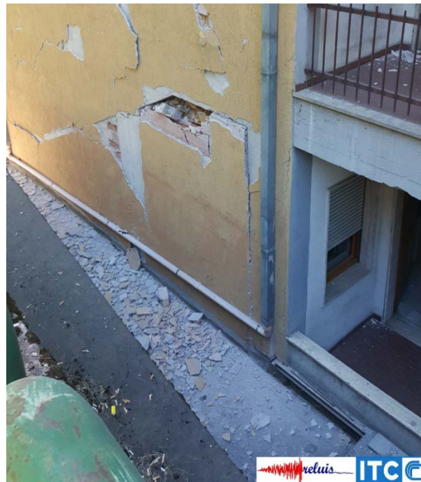
Figura 15 - Ospedale F. Grifoni, porzione in c.a.: incipiente ribaltamento fuori dal piano di tamponatura in laterizio in corrispondenza della trave a ginocchio della scala.
