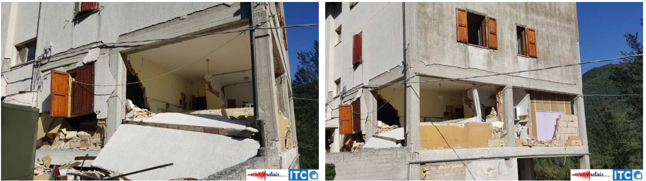
Figura 41 - Vista generale di un edificio in cemento armato danneggiato dal sisma
