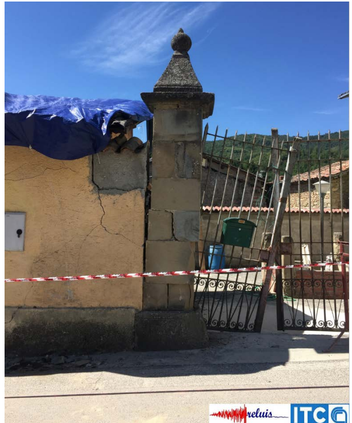
Figura 7 - Rotazione di colonna in muratura
