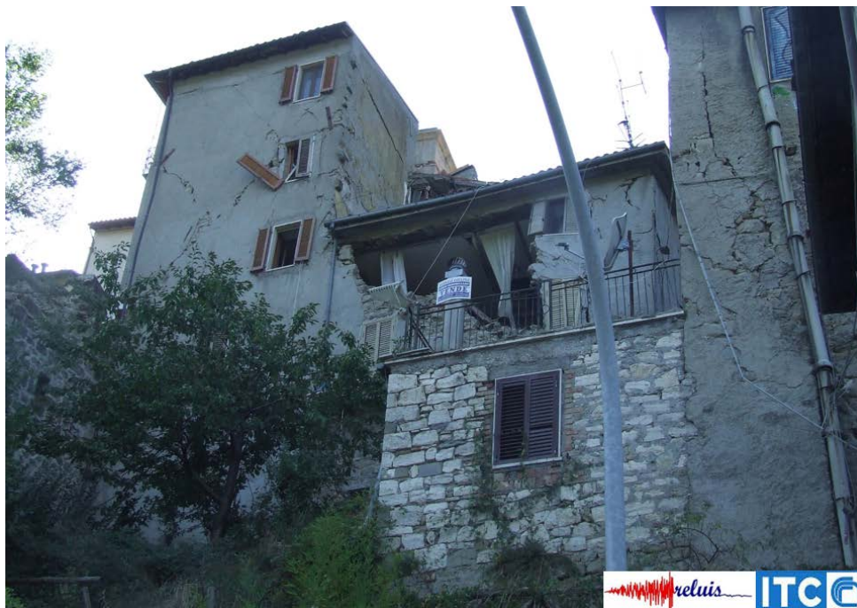
Figura 35 – Edificio in muratura: lesioni diagonali per crisi a taglio delle pareti perimetrali; crollo di parete perimetrale; danneggiamento di componenti non strutturali (infissi)
