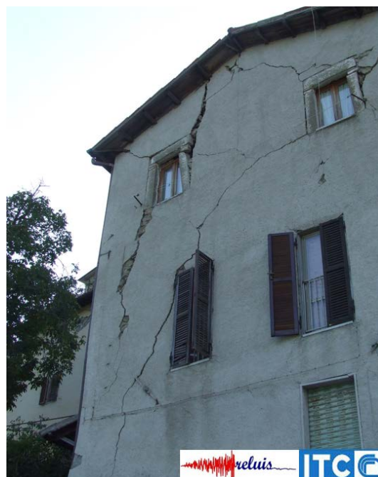
Figura 37 – Edificio in muratura: gravi lesioni diagonali per crisi a taglio
