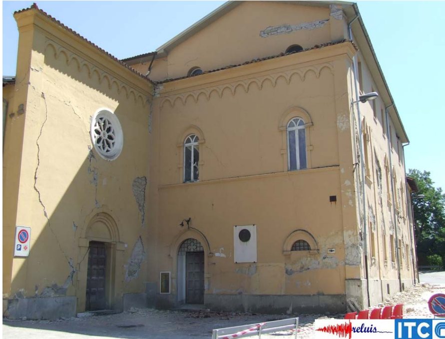
Figura 16 – Vista dell’ospedale F. Grifoni fortemente danneggiato dal sisma (porzione realizzata in muratura)
