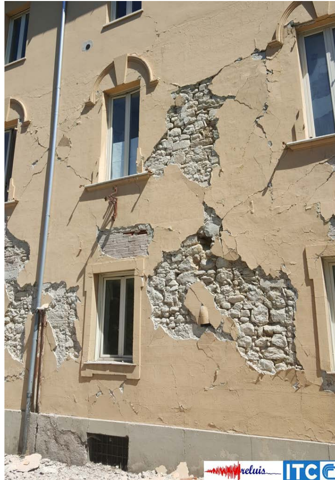
Figura 18 - Ospedale F. Grifoni, porzione in muratura: particolare delle crisi a taglio
