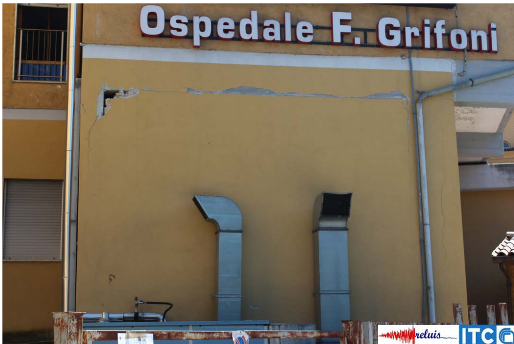
Figura 12 – Ospedale F. Grifoni, porzione in c.a.: distacco della tamponatura in laterizio dal telaio principale
