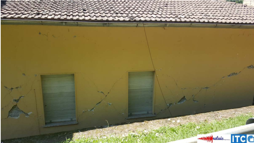
Figura 13 – Ospedale F. Grifoni, porzione in c.a.: fessure diagonali per crisi a taglio della tamponatura in laterizio
