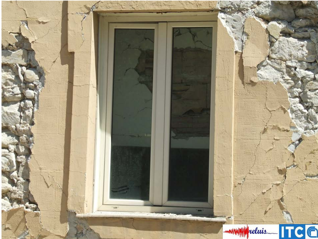
Figura 21 – Ospedale F. Grifoni, porzione in muratura: collasso dei solai visibile dalla finestra
