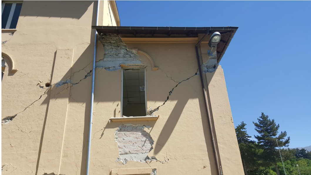
Figura 19 - Ospedale F. Grifoni, porzione in muratura: particolare della crisi a taglio
