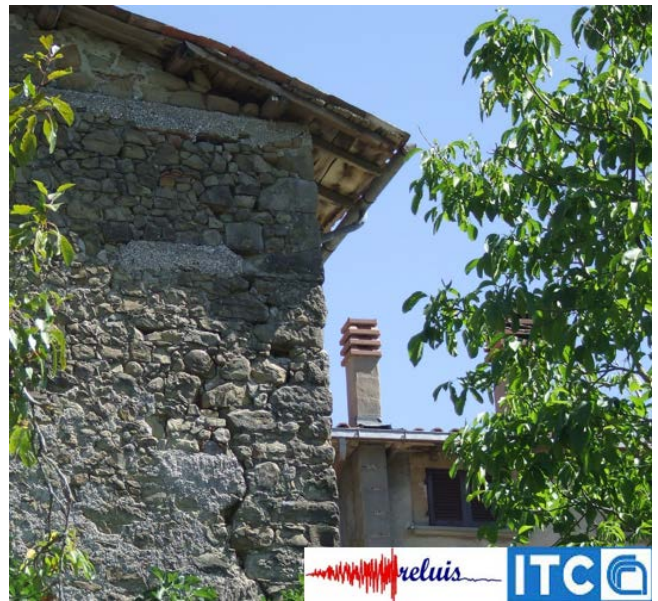
Figura 10 – Fessurazioni e danni lievi ad edificio in muratura
