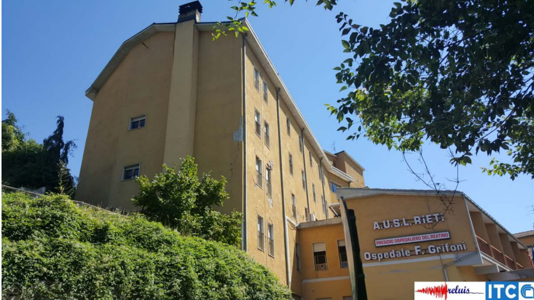
Figura 11 – Vista dell'ospedale F. Grifoni danneggiato dal sisma (porzione realizzata in c.a.)
