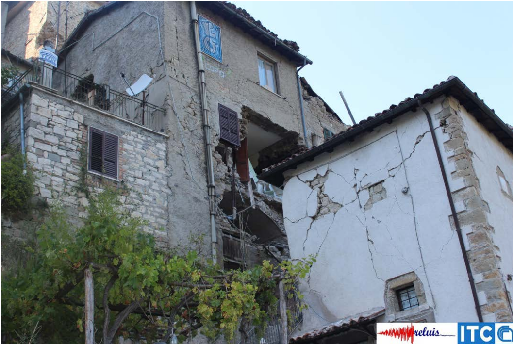
Figura 34 – Edificio in muratura: crollo di una porzione di solaio intermedio e di una porzione di parete perimetrale; crisi a taglio di pareti perimetrali
