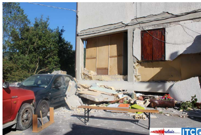
Figura 42 – Edificio in cemento armato: particolari del collasso delle tamponature su diverse facciate per ribaltamento fuori dal piano
