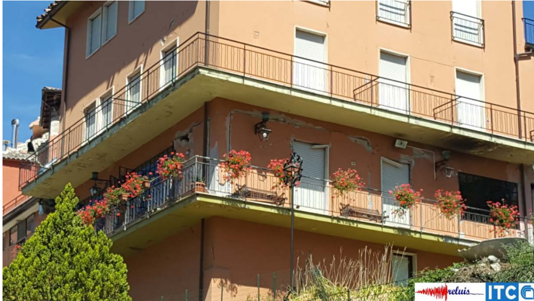
Figura 25 – Edificio in cemento armato: distacco della tamponatura dal telaio principale
