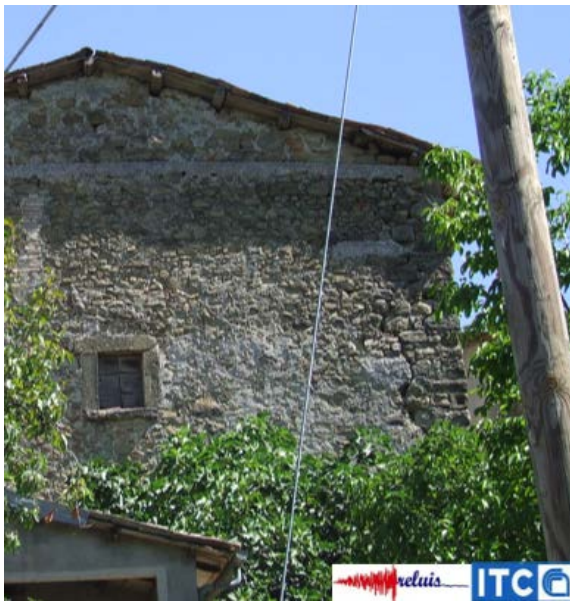
Figura 10 – Fessurazioni e danni lievi ad edificio in muratura
