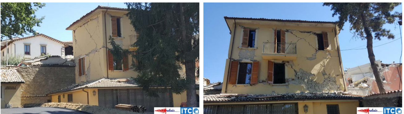
Figura 27 – Lesioni diagonali per crisi a taglio della muratura
