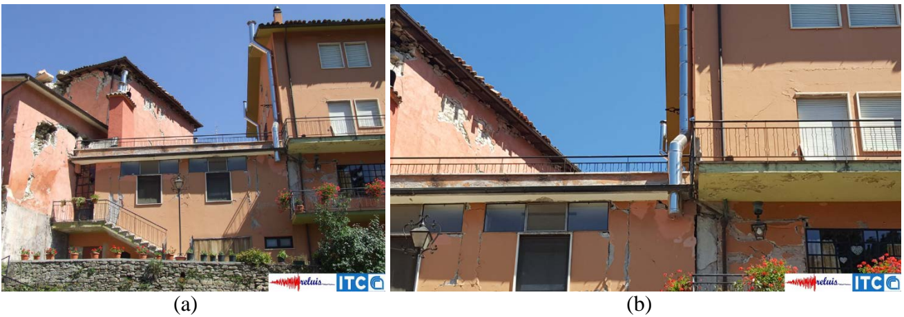
Figura 26 – Complesso di edifici in cemento armato e in muratura: (a) gravi dissesti per gli edifici in muratura; (b) rottura del nodo trave-pilastro per l'edificio in c.a.
