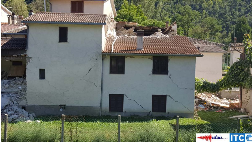
Figura 32 - Edificio in muratura: (a) crollo di una parete perimetrale e della relativa porzione di copertura; (b) lesioni diagonali per crisi a taglio delle pareti perimetrali e crollo di una porzione del piano sopraelevato
