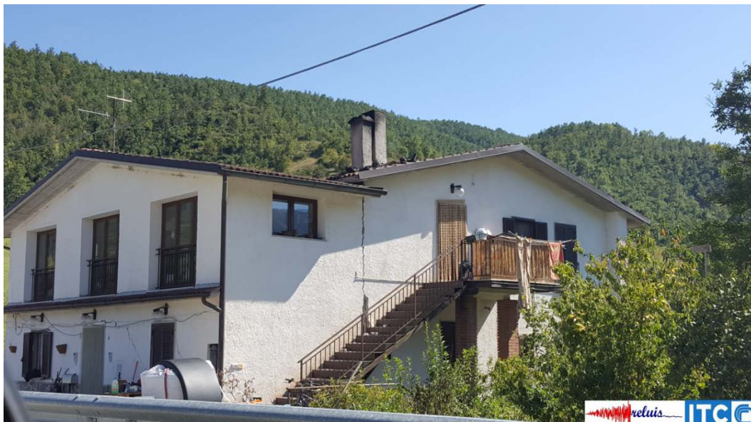
Figura 33 – Edificio in muratura: lesione verticale di distacco tra due porzioni
