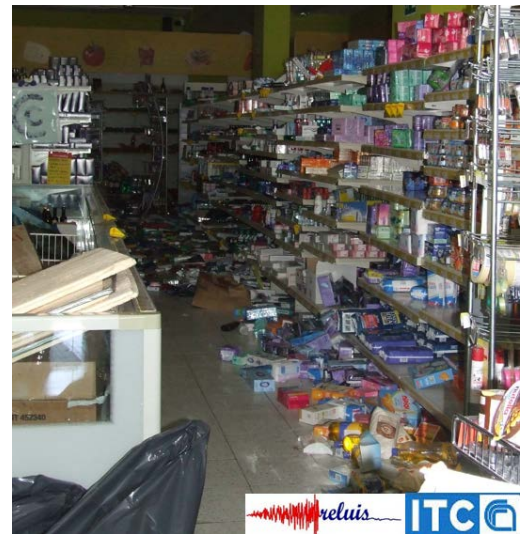
Figura 24 – Edificio in cemento armato: (a) vista generale dell'edificio rimasto intatto a seguito del sisma; (b) caduta di oggetti dagli scaffali
