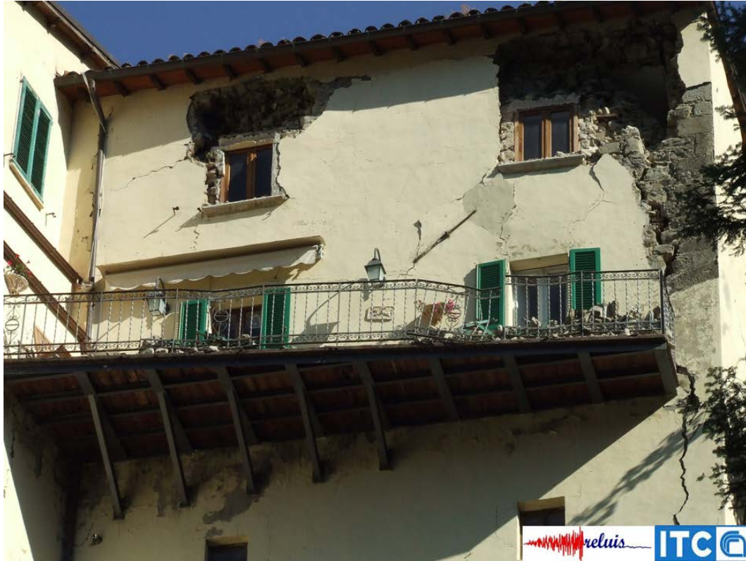
Figura 38 – Edificio in muratura: lesione verticale con incipiente meccanismo di ribaltamento fuori dal piano della parete esterna
