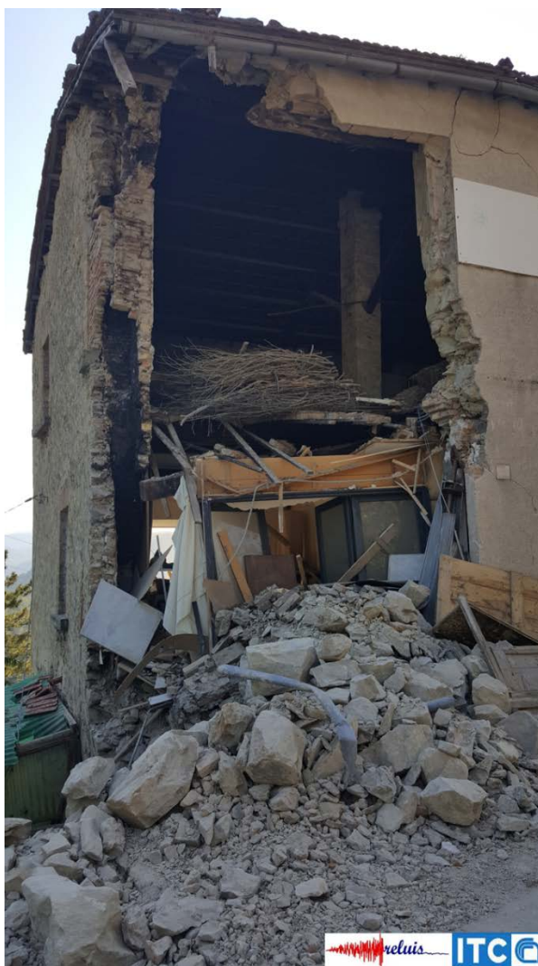
Figura 39 – Edificio in muratura: crollo di parete perimetrale
