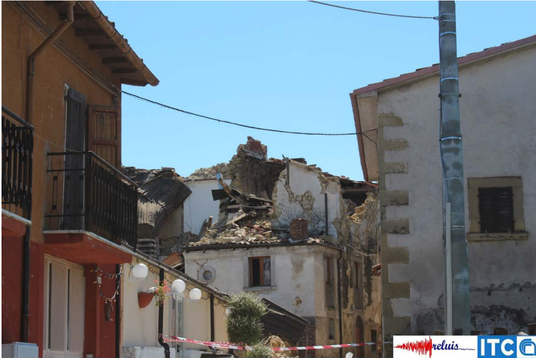
Figura 4 – Collasso del tetto e della porzione superiore di una struttura in muratura
