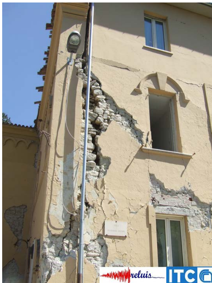
Figura 20 - Ospedale F. Grifoni, porzione in muratura: distacco di una parete dell'edificio
