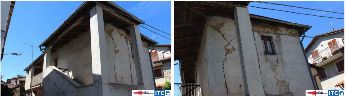
Figura 9 – Meccanismo incipiente di ribaltamento della facciata in un edificio in muratura
