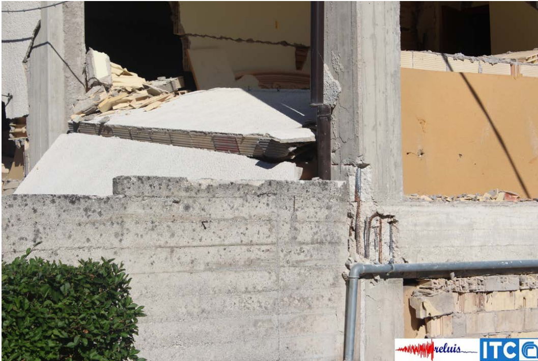
Figura 43 – Particolare dell'espulsione del coprifermo in corrispondenza del nodo trave-pilastro
