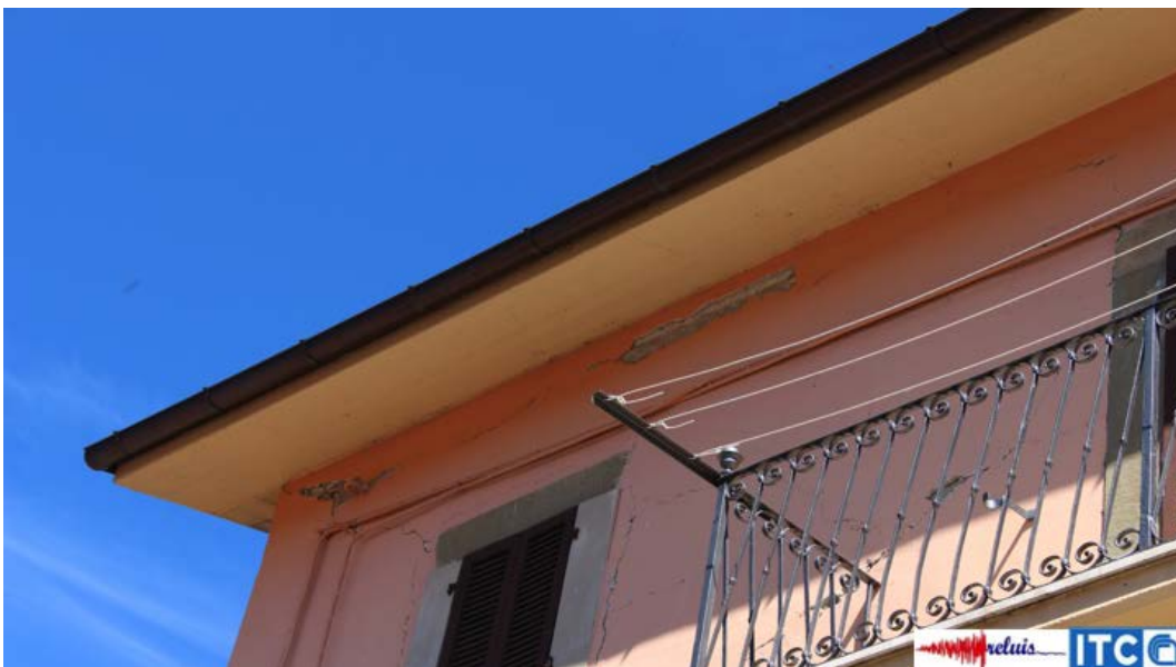
Figura 5 – Fessurazione orizzontale in corrispondenza di giunzione del tetto in edificio in muratura
