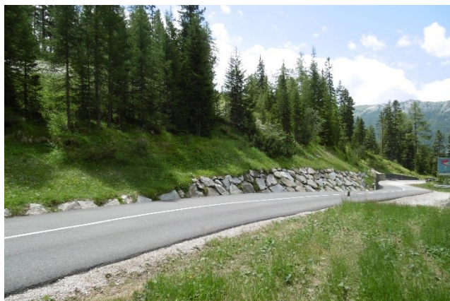
Foto 17: Trassenabschnitt östlich von Km 9+050; die Zyklopenmauer an der Bergseite wurde erst vor wenigen Jahren neu errichtet. / Tratto stradale ad est del Km 9+050; il muro in masso ciclopici a lato monte è stato costruito recentemente.
