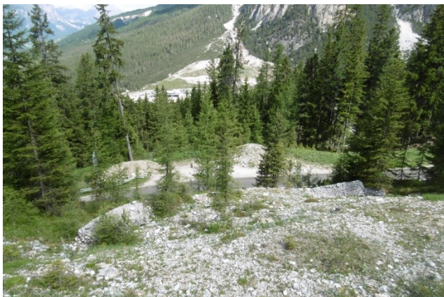
Foto 15: Übersichtsfoto der Rutschung mit verstellten Gabbionen. Blickrichtung Norden. / Foto panoramica dello scivolamento con i gabbioni spostati.
