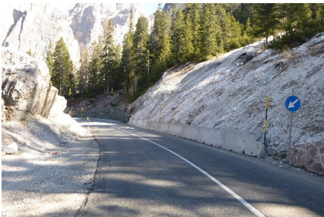
Foto 3: Die heutige Straße führt direkt am unteren Ende des Murkanals vorbei bzw. schneidet diesen an. Die geplante Variante wird talseitig vom großen Block am linken Bildrand vorbeigeführt. Im Bereich der heutigen Straße ist die Errichtung eines Schutzdamms mit dahinter liegendem Auffangbecken geplant. / La strada attuale corre direttamente al limite inferiore del canalone di colata detritica e/o lo taglia. La variante in progetto si svolgerà a lato valle del grosso blocco sul bordo a sinistra della foto. Nella zona della strada attuale è previsto un argine di protezione con bacino di raccolta a tergo.
