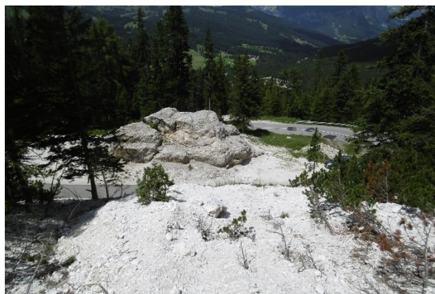
Foto 10: Murgraben, Blick von oben Richtung Straße. / Canalone di colata detritica, vista da sopra in direzione della strada.
