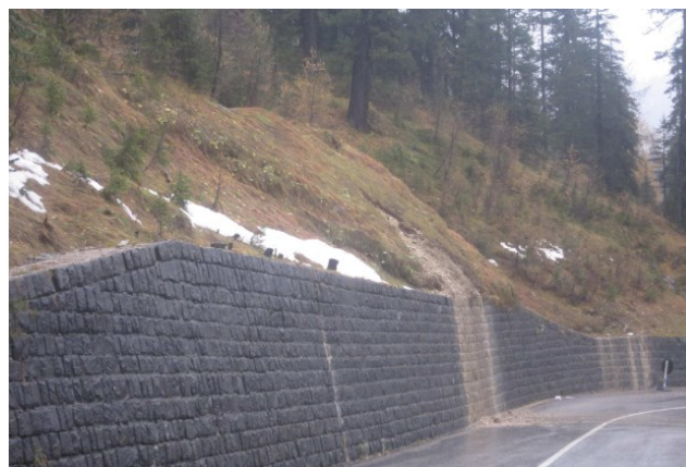
Foto 14: Foto der oberflächlichen Rutschung (aus Begehungsprotokoll Amt 11.6 vom 06.11.14). / Foto dello scivolamento superficiale (estratto dal protocollo di sopralluogo dell'Ufficio 11.6 del 06.11.14).
