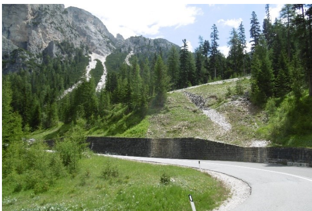
Foto 13: Oberflächliche Rutschung von 2014 bergseitig der Stützmauer bei km 8+950 mit dem sichelförmigen Anbruch. / Scivolamento superficiale nel 2014 a monte del muro di sostegno al km 8+950 con nicchia di distacco a forma di falce.
