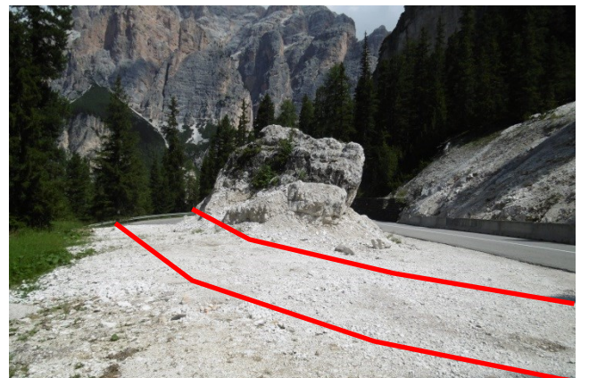
Foto 4: Geplanter Trassenverlauf und Anbindung an Bestandsstrecke im südlichen Abschnitt. / Tracciato in progetto e allacciamento al tracciato esistente nella sezione a sud.
