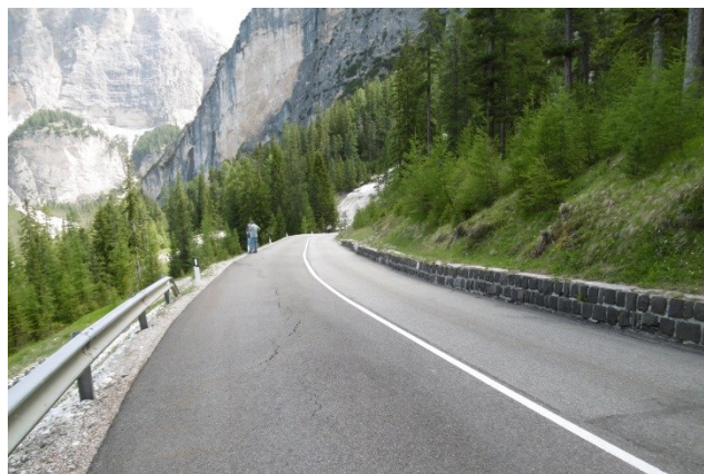
Foto 18: Leichte Setzungen und Risse der talseitigen Fahrbahn im Abschnitt von ca. Km 9+220 bis 9+320. Bergseitig wird die Straße von einer ca. 0,5 m hohen Natursteinmauer begrenzt; die dort feststellbaren Schäden (vor allem Risse) sind altersbedingt. / Leggeri cedimenti e lesioni nella carreggiata a lato valle nella sezione fra il km 9+220 e 9+320. A lato monte la strada è delimitata da un muro in pietra naturale alto 0,5 m; i danni rilevati qui (soprattutto lesioni) sono imputabili all'età.
