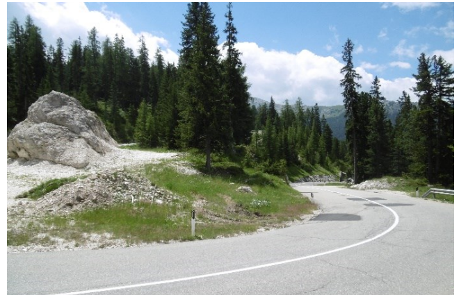
Foto 2: Bereich der geplanten Variante bei Km 9,2. Die Neutrassierung erfolgt talseitig (rechts) vom großen Block. / Zona della variante in progetto al km 9,2. Il nuovo tracciato si estende al lato valle (destra) del grosso blocco.
