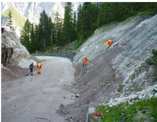
Foto 11: Reparatur des Steinschlagnetzes im Bereich der bergseitigen Straßenböschung nach dem Ereignis am 22.07.13 (entnommen aus Begehungsprotokoll Amt 11.6 vom 23.07.13). / Riparazione della rete di protezione contro caduta massi nella zona della scarpata stradale a lato monte dopo l'evento del 22.07.13 (estratto dal protocollo di sopralluogo dell'ufficio 11.6 del 23.07.13).
