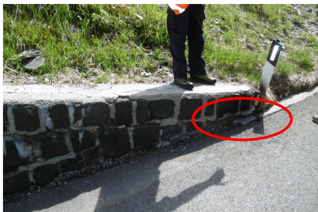
Foto 19: Leicht über den Straßenbelag überschobene Stützmauer bei ca. Km 9+450. / Muro di sostegno leggermente ribaltato al km 9+450.
