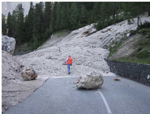
Foto 12: Vermurung der Straße durch Folgeereignis am 04.08.13 (entnommen aus Begehungsprotokoll Amt 11.6 vom 05.08.13) / Colata detritica che ha raggiunto la sede stradale durante l'evento successivo del 04.08.13 (estratto dal protocollo di sopralluogo dell'ufficio 11.6 del 05.08.13).
