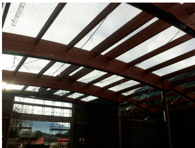
Figura 5.3.2-1 - Esempio di sistema S: copertura in legno
