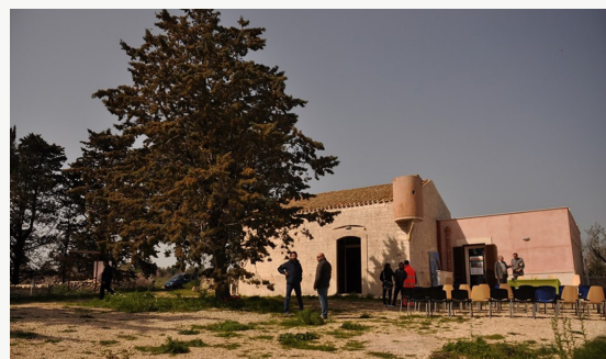
Figura 2 - Il Centro visita del Parco Nazionale dell’Alta Murgia “Torre dei Guardiani” costruzione risalente alle fine del 1800 usata come caserma e alloggio per le guardie campestri, recuperata secondo i principi dell’abitare sostenibile e della bioarchitettura.
