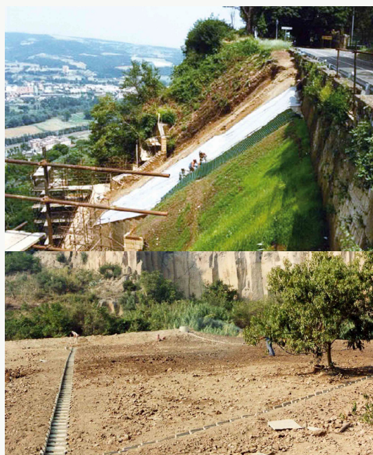
Figura 2 – Esempio di intervento di ingegneria naturalistica sulla Rupe di Orvieto per la stabilizzazione del pendio e la regimentazione delle acque
