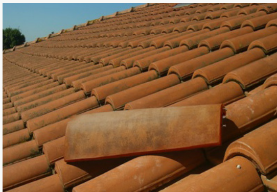
Figura 2 - Coppi fotovoltaici
