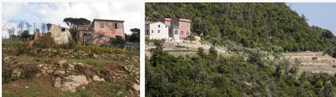
Figure 1-2 - Viste di Casa Lovara, prima (sinistra) e dopo (destra) gli interventi di restauro e valorizzazione
