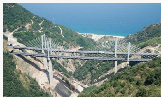
Figura 2 – Il nuovo viadotto Favazzina, dopo la demolizione del vecchio viadotto
