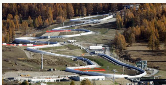
Figura 1 - La pista da bob allo stato attuale
