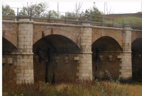
Figura 3 – Viadotto lungo la linea ferroviaria Foggia-Potenza
