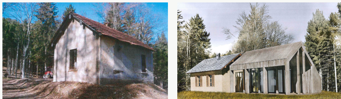
Figure 2-3 – Esempio di progetto per il recupero di una baita sugli alloggi del Mottarone (Baita Maria: a sinistra stato di fatto, a destra progetto di recupero e ampliamento)
