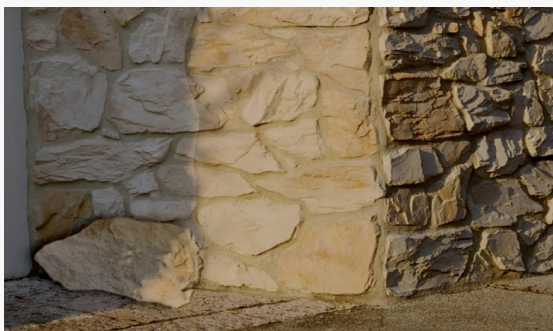
Figura 3 - Rivestimento in pietra con componente fotovoltaica integrata mimetizzata
