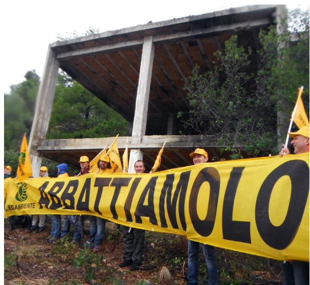
Legambiente per la demolizione degli scheletri nel Parco nazionale del Circeo
