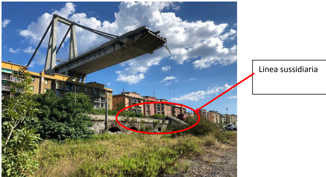
Figura 2 – viadotto sospeso sopra la linea “Sussidiaria
