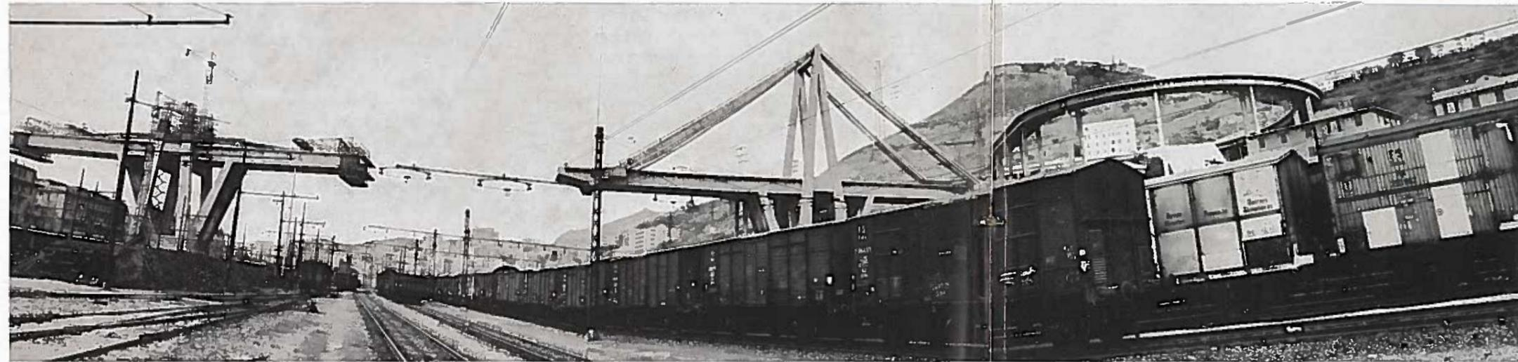
Si sono infatti prefabbricate ed indi varate (a mezzo di uno speciale carroponete, ideato per l'occasione dal Direttore del cantiere) tutte le varie nervature e parimenti si sono prefabbricate, in lastre delle dimensioni di 1,45 m per 2,90 m, le solette di impalcato. I dettagli di giunzione dei vari elementi appaiono nelle varie figure e sono stati oggetto di speciale studio.
