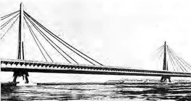
27 - Il progetto del viadotto della cornice di Jeddah in Arabia Saudita, di circa 2 Km di lunghezza totale; la campata principale di 220 m di luce; 23-25 - Il viadotto della cornice di Jeddah, particolare della pila e sezioni trasversali dell'impalcato: a) sezione tipo; b) sezione in corrispondenza delle pile principali.
