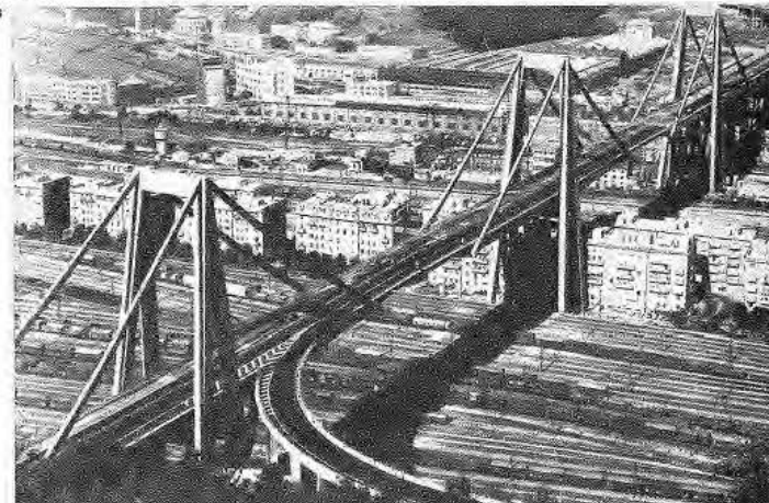
11-12-13 - Il viadotto sul Polcevera, con una lunghezza di circa 1300 m ed una altezza di 60 m dal fondo valle, attraversa senza soluzione di continuità, strade, ferrovie, edifici ed il fiume omonimo.
