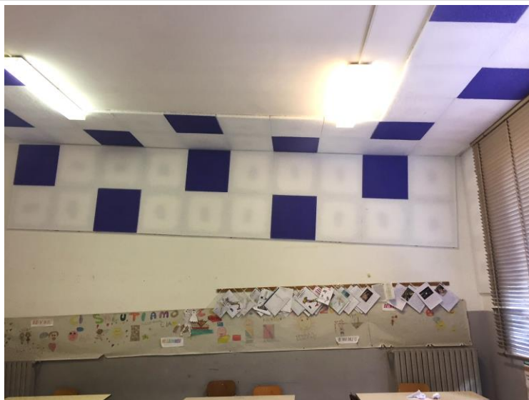
Fig. 19 Particolare dell'aula al primo piano dell'IC di Pellezzano - Plesso Scuola Primaria sito in via della Quercia a Capezzano (Pellezzano – SA) a valle dell'intervento
