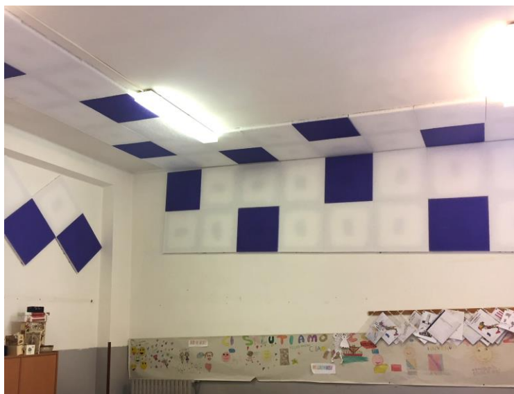
Fig. 20 Particolare dell'aula al primo piano dell'IC di Pellezzano - Plesso Scuola Primaria sito in via della Quercia a Capezzano (Pellezzano – SA) a valle dell'intervento
