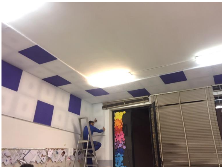
Fig. 21 Particolare dell'aula al primo piano dell'IC di Pellezzano - Plesso Scuola Primaria sito in via della Quercia a Capezzano (Pellezzano – SA) a valle dell'intervento
