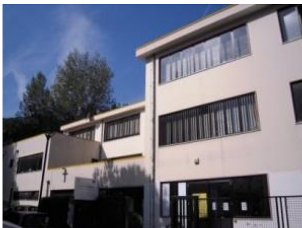
Fig. 4 Vista esterna dell'Istituto Comprensivo di Pellezzano - Plesso Scuola Primaria - sito in via della Quercia a Capezzano (Pellezzano – SA).
