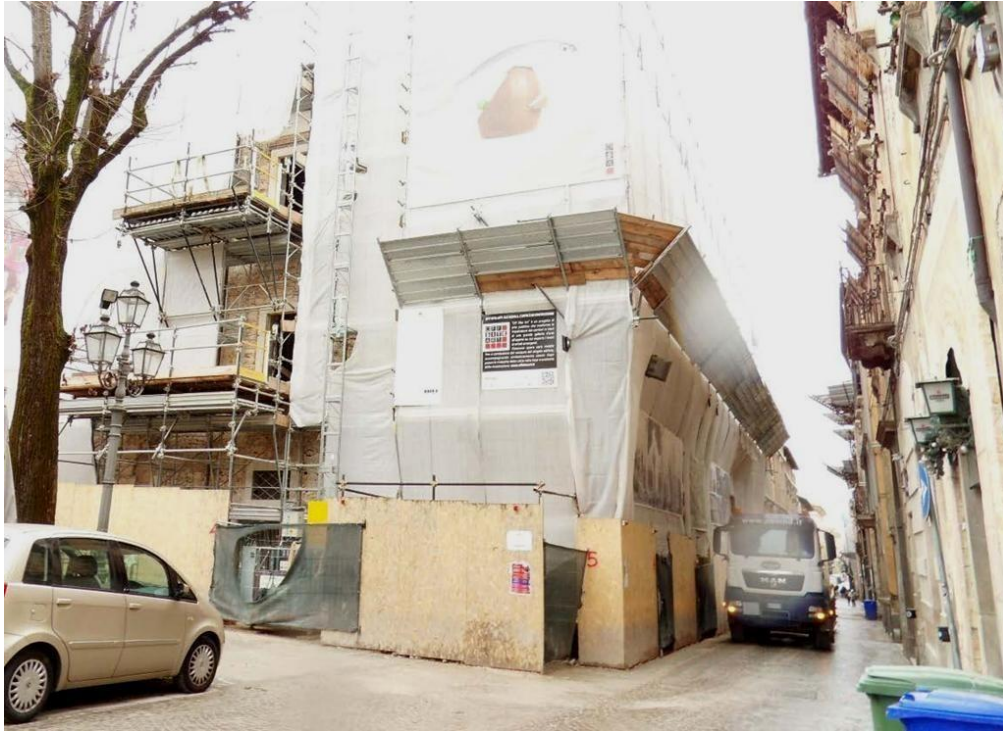
FOTO 2 - FACCIATA PRINCIPALE DI PALAZZO MANNETTI DURANTE L'ESECUZIONE DEI LAVORI
