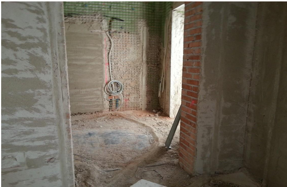
FOTO 3 - INTERNO DI PALAZZO MANNETTI DURANTE L'ESECUZIONE DEI LAVORI
