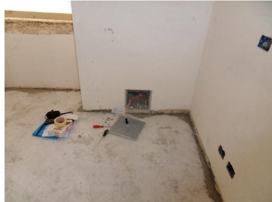
FOTO 5 - PIASTRA E BOX CHE ACCOGLIE IL SENSORE ACCELEROMETRICO
