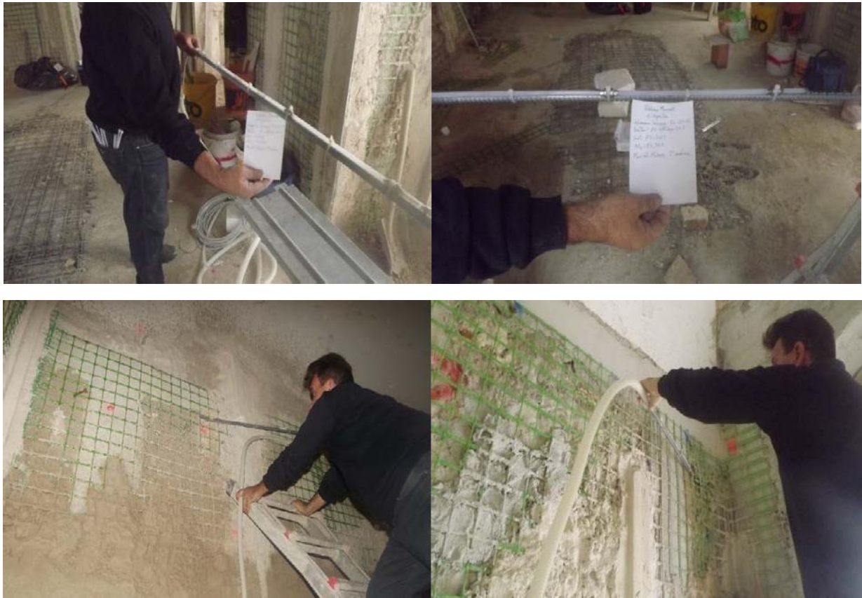
FOTO 4 - FASI DI INSTALLAZIONE DEI SENSORI A FIBRA OTTICA
