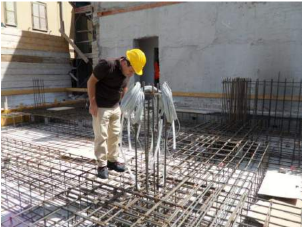
Montaggio sistema di monitoraggio sulle fondazioni – viste 2 - 3
