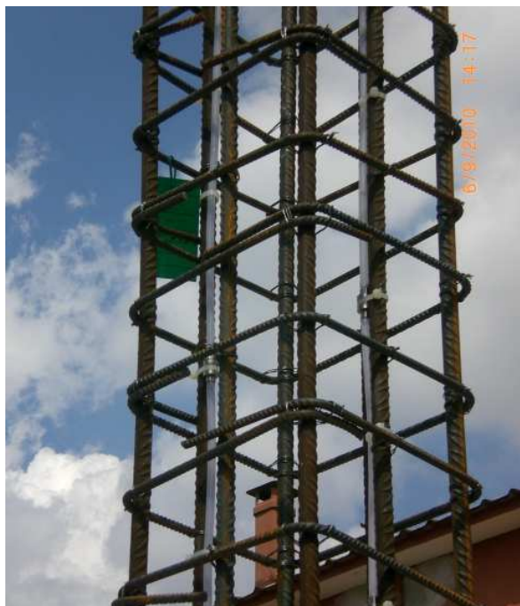
Gabbie montate con la predisposizione del sistema di monitoraggio – viste 12– 13
