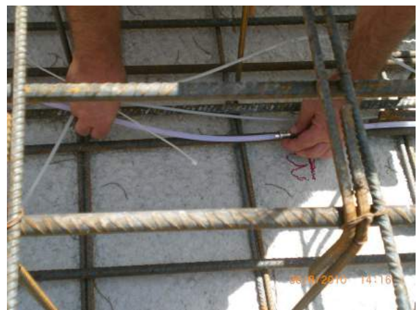
Dettaglio montaggio sistema di monitoraggio sulle fondazioni – viste 4 - 5
