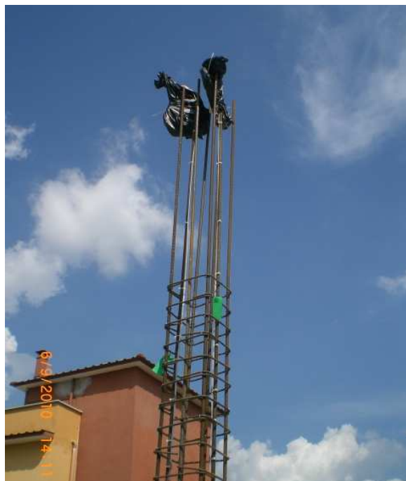
Gabbie montate con la predisposizione del sistema di monitoraggio – viste 12– 13
