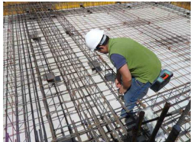
Montaggio sistema di monitoraggio sulle fondazioni – viste 2 - 3
