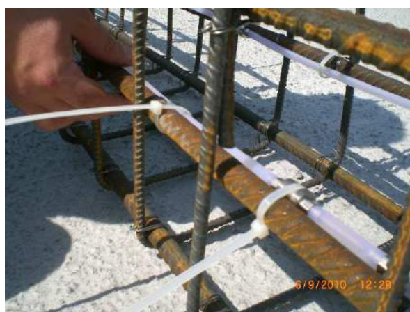
Gabbie pilastri su cui installare le fibre ottiche e dettaglio installazione – viste 8 - 9
