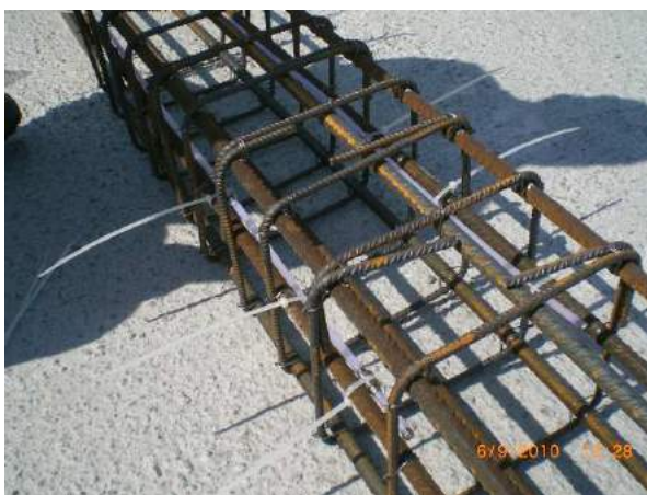
Gabbie pilastri su cui installare le fibre ottiche e dettaglio installazione – viste 8 - 9
