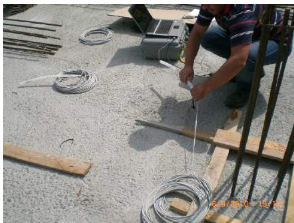
Montaggio controller e catalogazione per setup sistema di monitoraggio – viste 10 - 11
