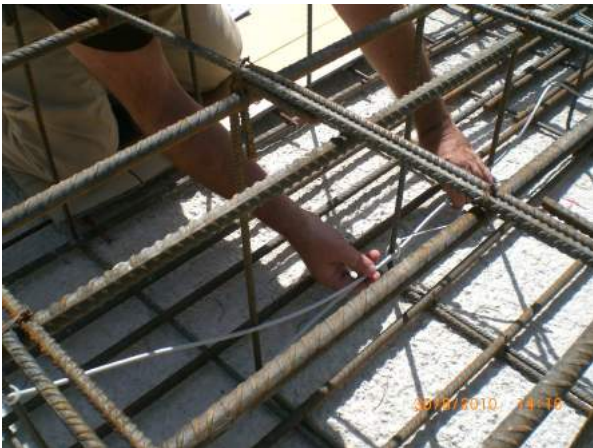
Dettaglio montaggio sistema di monitoraggio sulle fondazioni – viste 4 - 5
