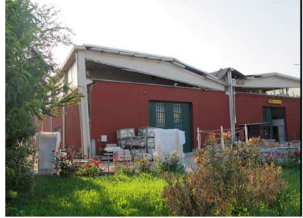
Figura 6-16 – Crolli per perdita di appoggio delle travi su pilastri.
