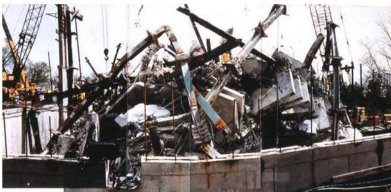
Figura 6-30 – Collasso della struttura dell'Ambiance Plaza ( www.bfrl.nist.gov/861/861pubs/collapse/workshop/7.L'AmbiancePlazaCaseStudy060913.pdf )
