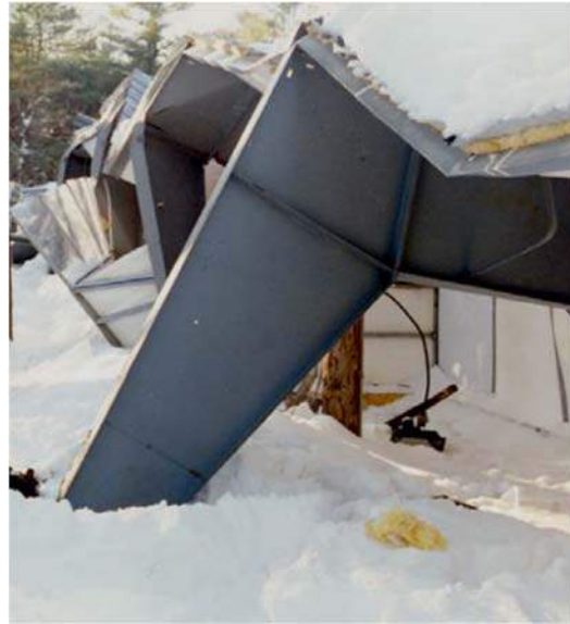
Figura 6-33 – a) dettagli della struttura del Jackson Landing Skating Rink; b) collasso dei telai trasversali (Ellingwood et al., 2007)
