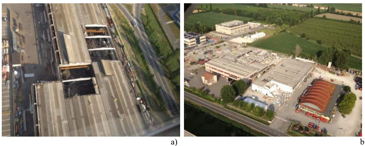
Figura 6-15 – Crolli di elementi prefabbricati di copertura localizzati sovente in corrispondenza di irregolarità in pianta dei fabbricati: a) caduta di elementi di copertura in presenza di irregolarità in pianta; b) crollo di una porzione di capannone a due piani (a sinistra) e delle campate laterali di un altro capannone (a destra)
