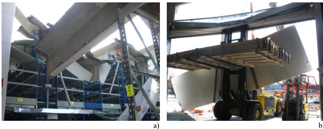
Figura 6-21 – Crolli per azioni eccezionali (non sismiche): a) collasso per azione della neve che ha causato compressioni non sopportabili dall'appoggio di una trave su un pilastro; b) caduta di un pannello di tamponamento urtato dalle forche di un carrello elevatore
