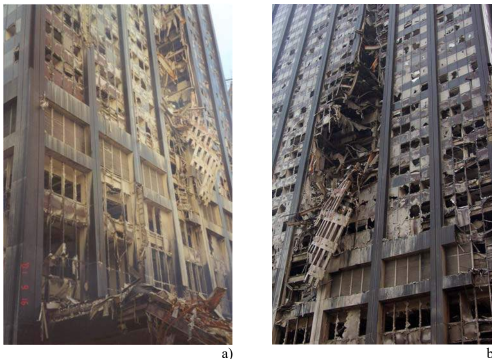
Figura 6-37 – Collasso parziale delle strutture perimetrali dell’edificio in 130 Liberty Street (immagine a) da Ellingwood et al., 2007, immagine b) da FEMA Photo Library. https://www.fema.gov/media-library/search/4019#{"keywords":"4019"} )
