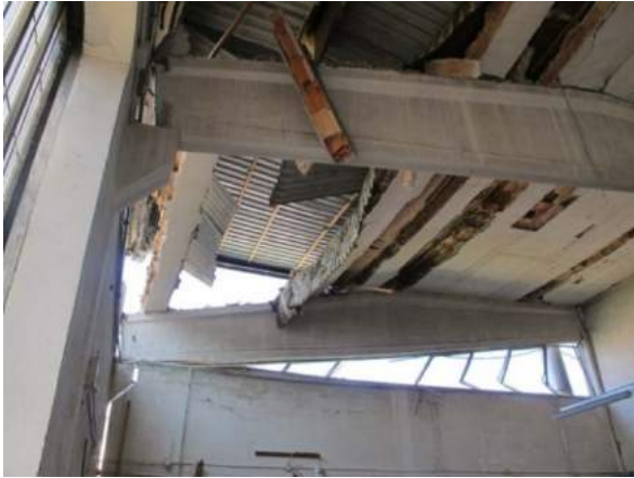
Figura 6-16 – Crolli per perdita di appoggio delle travi su pilastri.
