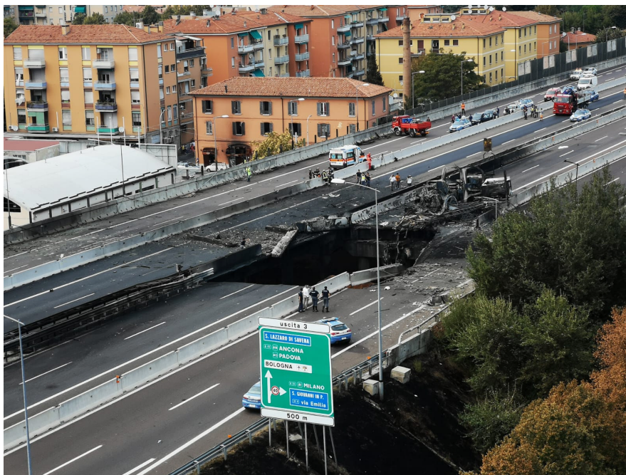
Figura 9 – Lo squarcio nel viadotto
