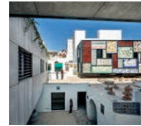
Hotel e ristorante nell'antica fabbrica Montalván Hotel and restaurant in the ancient Montalván Factory AF6 Arquitectura
