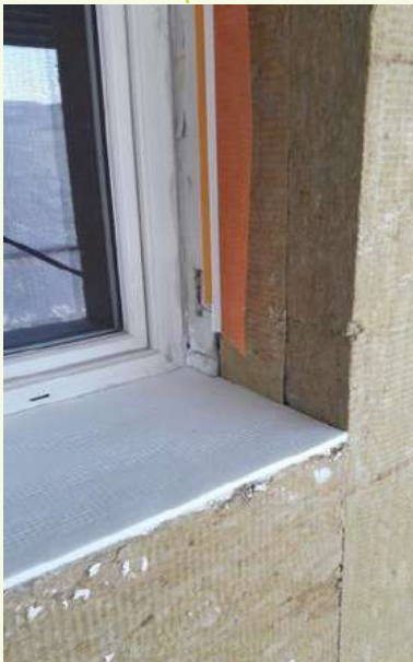
Isolamento della spalletta e del davanzale
