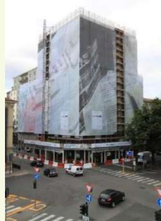
La fase di cantiere
