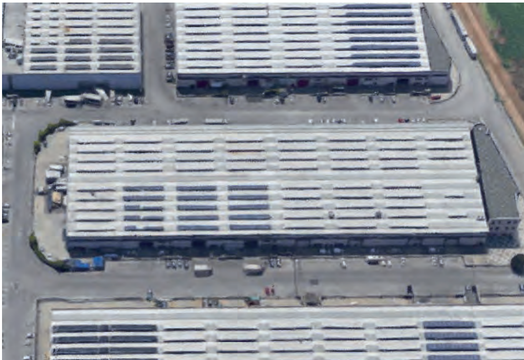
VISTA AEREA DEL SITO PRODUTTIVO
