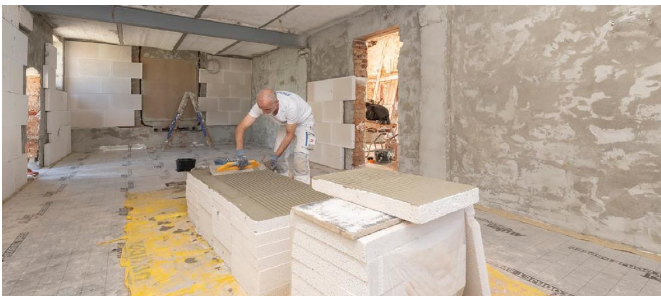
Figura 7 Esempio di posa in opera di pannelli isolanti minerali a capillari attivi. In alto l'ambiente esistente con in evidenza la parete perimetrale in mattoni pieni degradata da umidità e sali; in basso una fase di posa in opera dei pannelli. Fonte: Xella
