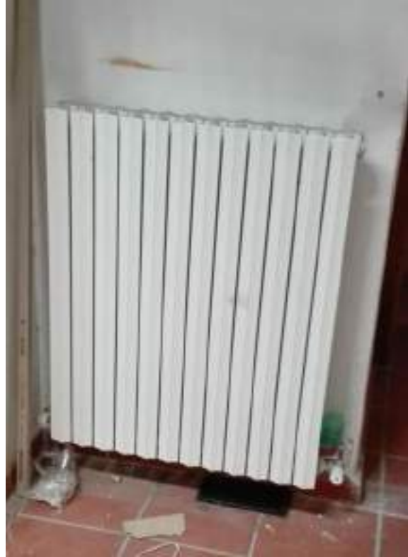
Fig.8 – Caloriferi in ghisa all'interno dell'immobile
