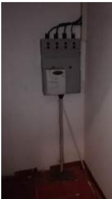
Fig. 11 – Punto di consegna del distributore con il contatore di consumi
