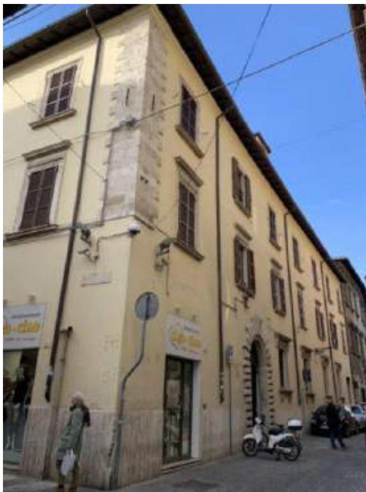
Fig. 1 – L'Edificio in oggetto in cui è inserita la Guardia di Finanza di Ascoli Piceno
