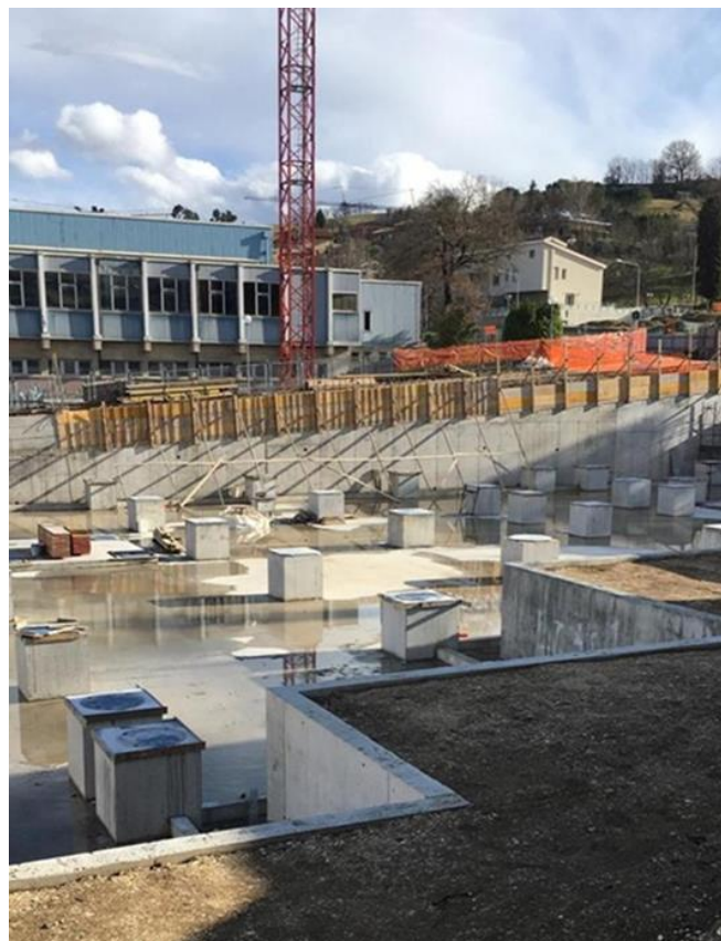
Isolatori sismici - Itis San Severino
