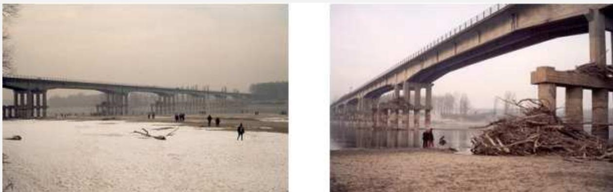
*Figura C.11 - Ponti con significativo abbassamento generalizzato dell'alveo.*
