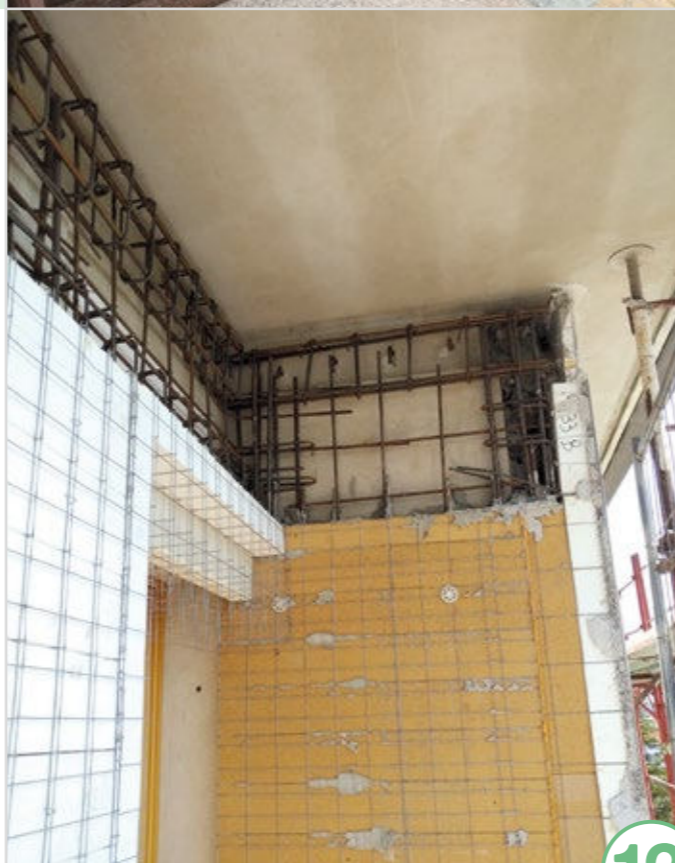
10 Pannello con calcestruzzo spruzzato per applicazione interna
