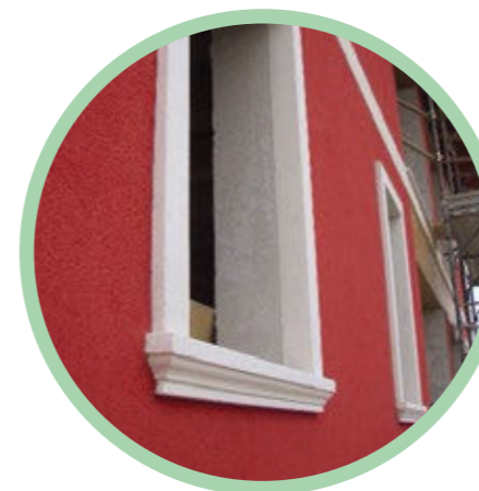
Rivestimento in INTONACO A VISTA
