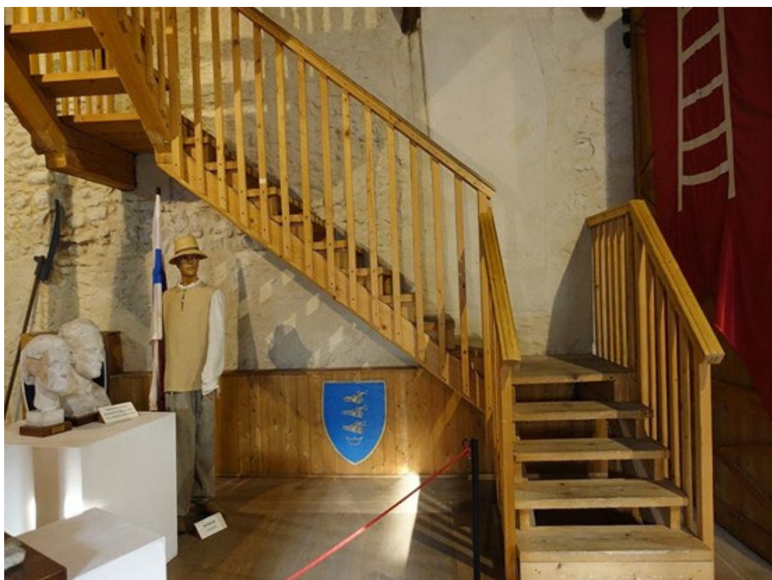
PIANO SOTTOTETTO - Scala per l'accesso al cammino di ronda
