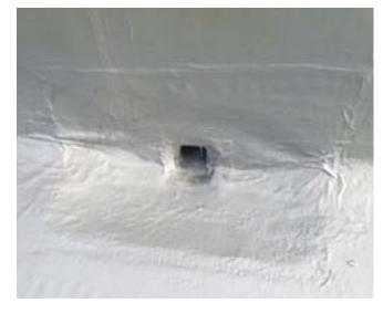
scarichi a parete prevedere l'installazione dei bocchettoni angolari a parete specifici per impermeabilizzanti liquidi **Scarico a parete** (Art. 0818 002 952). I punti critici, o dove il prodotto è particolarmente sollecitato meccanicamente, devono essere rinforzati con TNT da 100 - 130 g/m² (giunti, raccordi con elementi verticali, ecc.) o bandelle elastiche, in base alle esigenze, inseriti tra due strati di **Witanflex ALUMET**.
