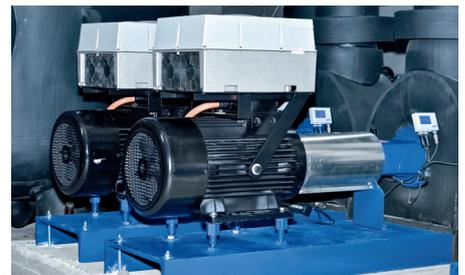
2 pompe Etanorm PumpDrive per funzionamento continuo con motori KSB SuPremE® IE5\* ad alta efficienza
