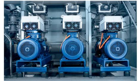
Tutte le pompe Etanorm sono dotate del sistema a velocità variabile PumpDrive.
