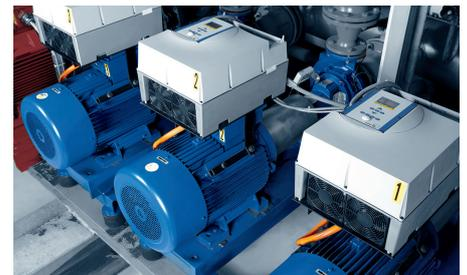
Ogni pompa è progettata per una portata di 100 m³/h.
