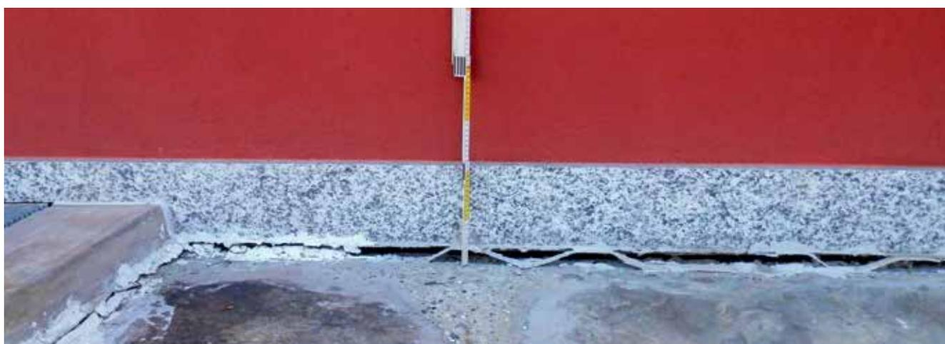
**L'intervento di consolidamento di pavimenti e marciapiedi, mediante iniezioni di resine espandenti Leo.Mac Multilevel**, garantisce il miglioramento delle caratteristiche tecniche del terreno, lungo tutto il tratto, compreso tra la base della pavimentazione e la profondità di progetto.
