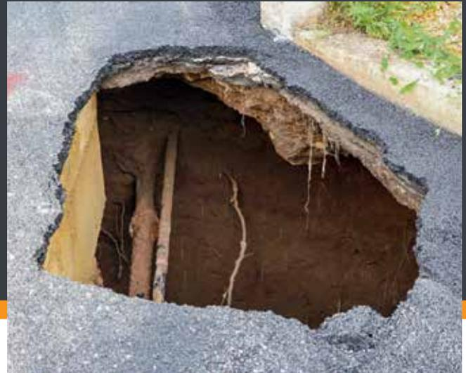
Con la tecnologia Leo.Mac è possibile riempire cavità e vespai, mediante iniezioni di resina ad elevato coefficiente di espansione. Il riempimento, avvenendo con resina ad alta espansione, non appesantisce il terreno sottostante.
